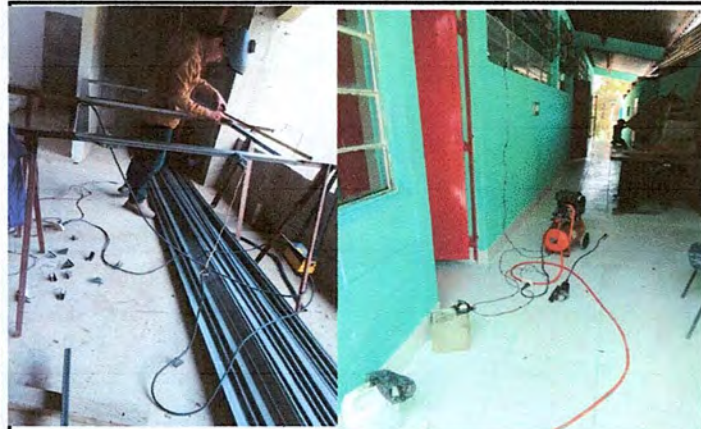
Foto 1: MEJORAMIENTO DE PUERTAS
