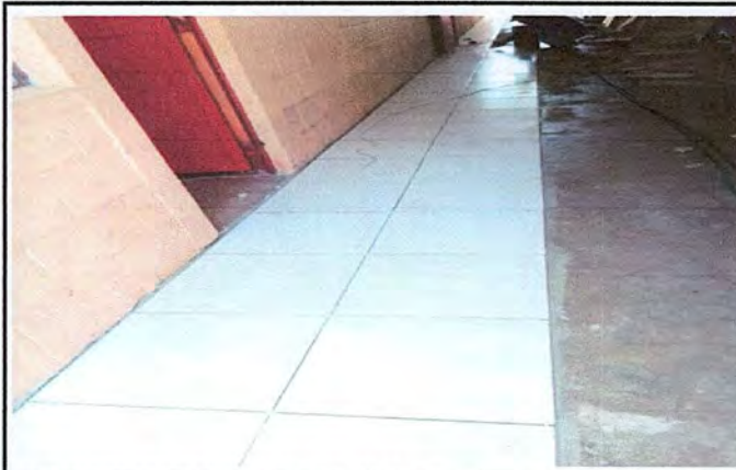
Foto 2: MEJORAMIENTO DE PISO
